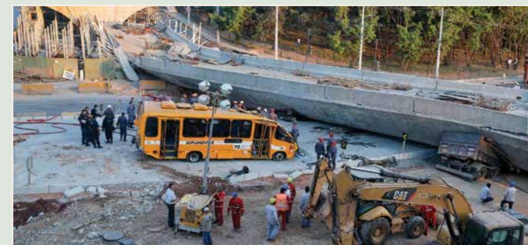
Desabamento de viaduto em BH: é preciso adotar a proteção coletiva dos trabalhadores
